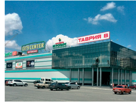
Торговельно-розважальний центр «City Center» м. Одеса, вул. Кримська
