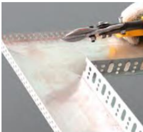
Рисунок 10. Перфорований профіль, підготовлений до установки.
