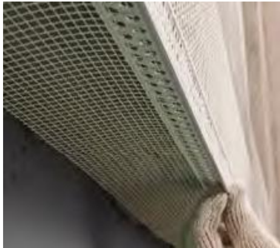
Рисунок 7. Посилення елементів фасаду.
