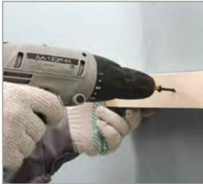
Рисунок 4. Метод конверта по допоміжній рейці.
