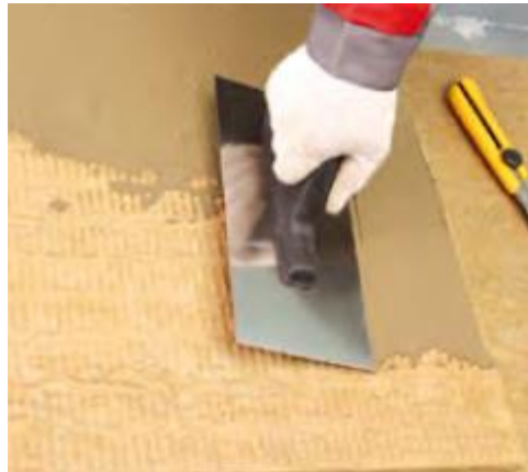
Рисунок 11. Підготовка поверхні утеплювача.
