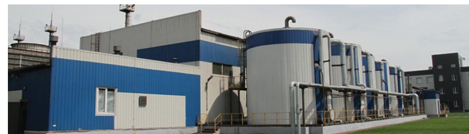
■ Газотурбинна електростанція, Луганська обл., м. Алчевськ
